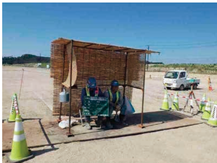
在实际施工现场所进行的对策（设置休息场所）
